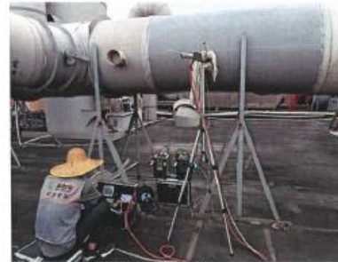
DA010废气处理前采样口
