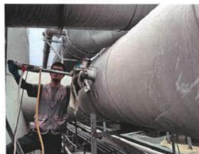
DA016废气处理前采样口
