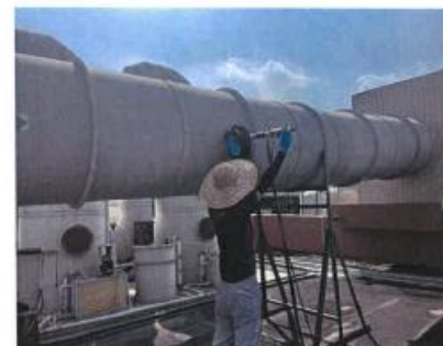
DA012废气处理前采样口
