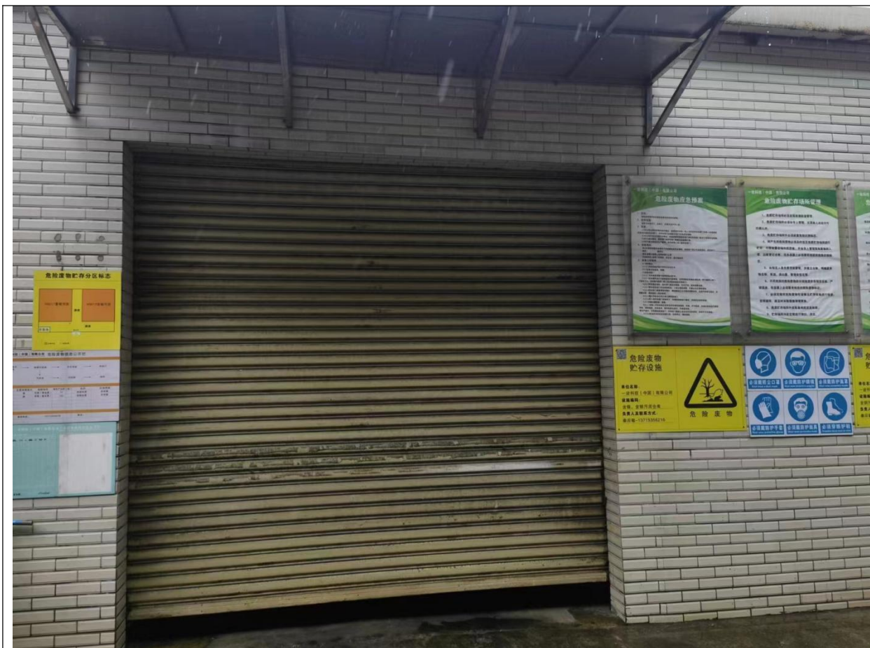
含镍、含银污泥仓库
