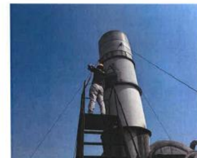
DA012废气处理后采样口
