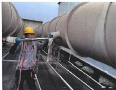
DA002废气处理前采样口
