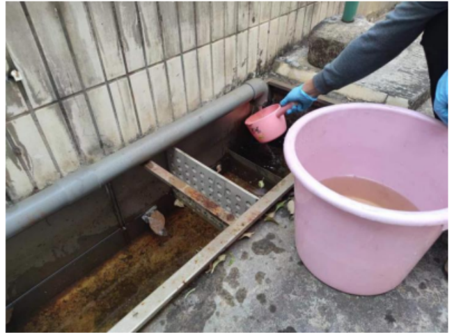
图 2 DW001 综合废水排放口★
