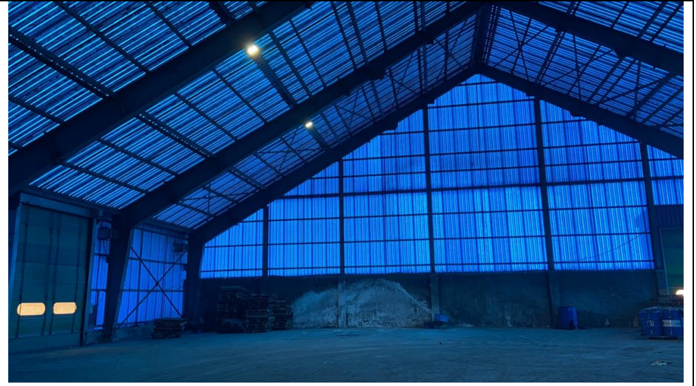
一般固废暂存库内部
