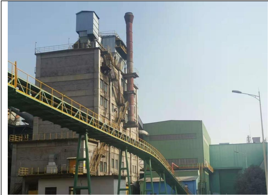
市政污泥暂存库
