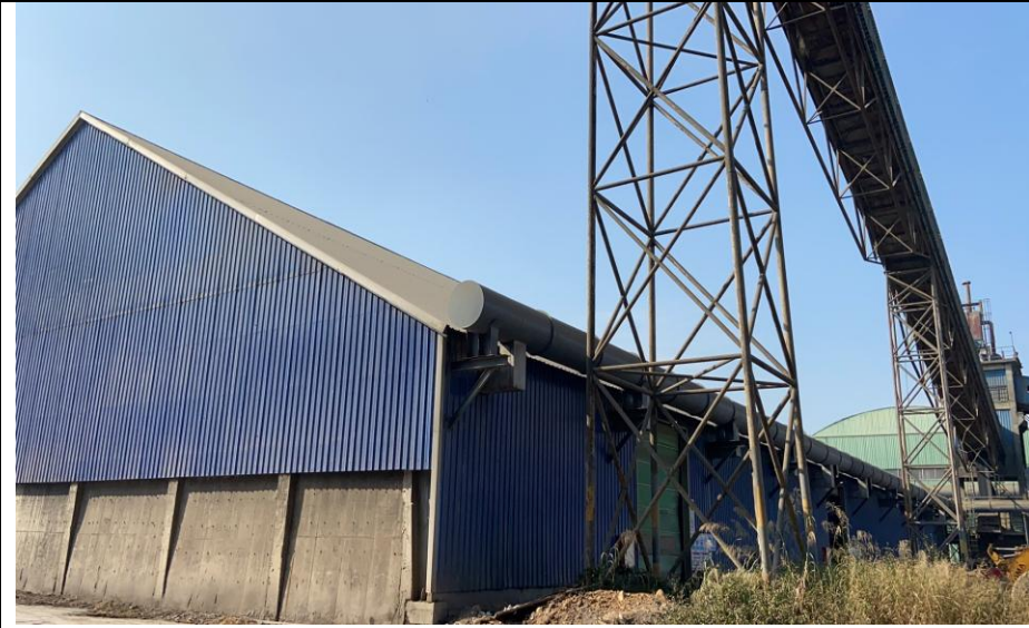
一般固废暂存库
