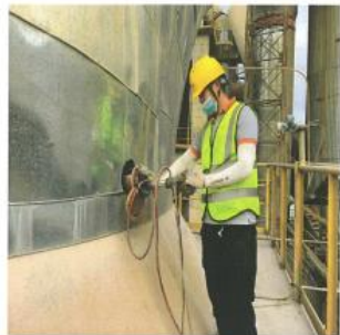
图1 水泥窑窑尾废气处理前采样口(处理前)
