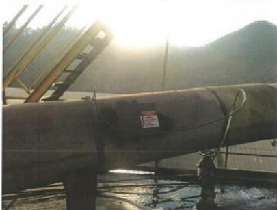
图3 市政污泥暂存库废气治理设施：喷淋
