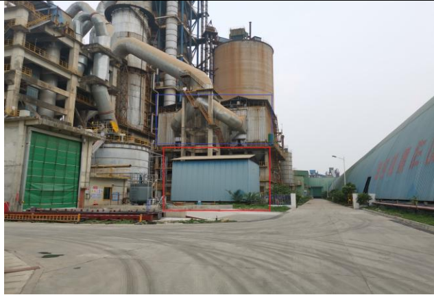
一般固废暂存库备用废气处理设施（活性炭吸附）
