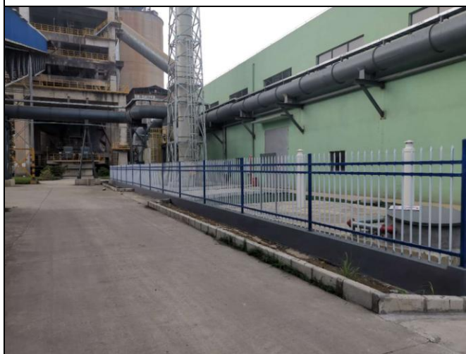
初期雨水收集池
