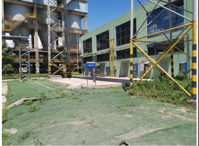
初期雨水收集池
