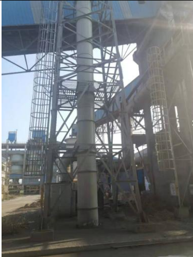
一般固废暂存库备用废气处理设施（活性炭吸附）
