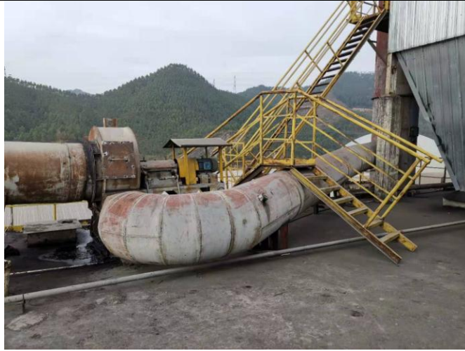
市政污泥暂存库备用废气处理设施（植物液喷淋）
