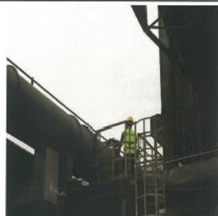
图3 一般固废暂存库备用废气处理设施前采样口(处理前)
