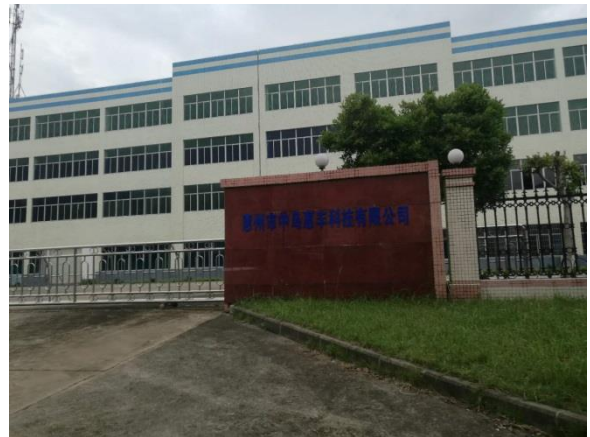
项目西北侧惠州市中乌惠丰科技有限公司
