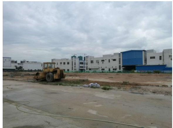
项目新厂区现状
